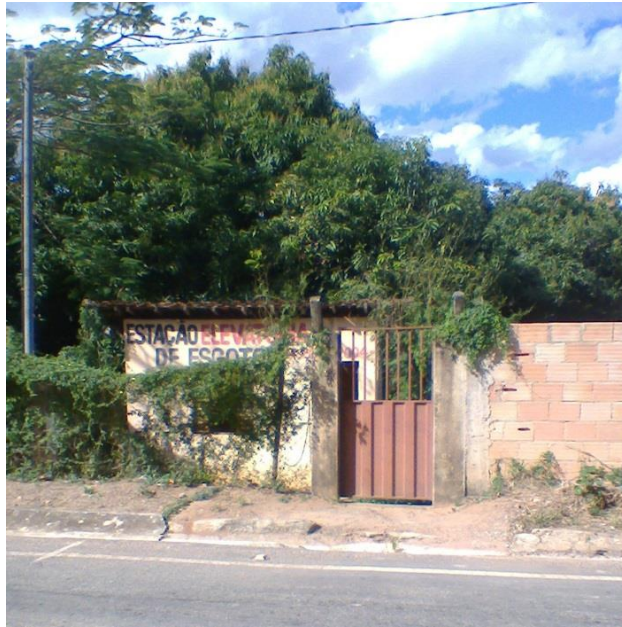
Figura 29: Estação Elevatória de Esgoto (E.E.E) na Avenida Sete de Setembro.
