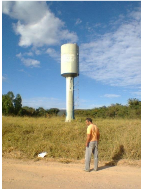
Figura 18 – Reservatório 2 Localidade de Catita de Cima
