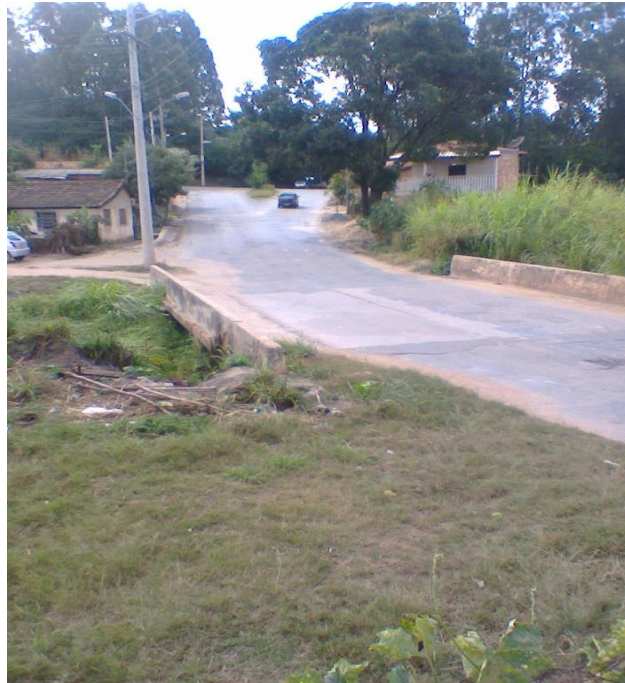
Figura 51 - Ponte na parte central Bairro Poção
