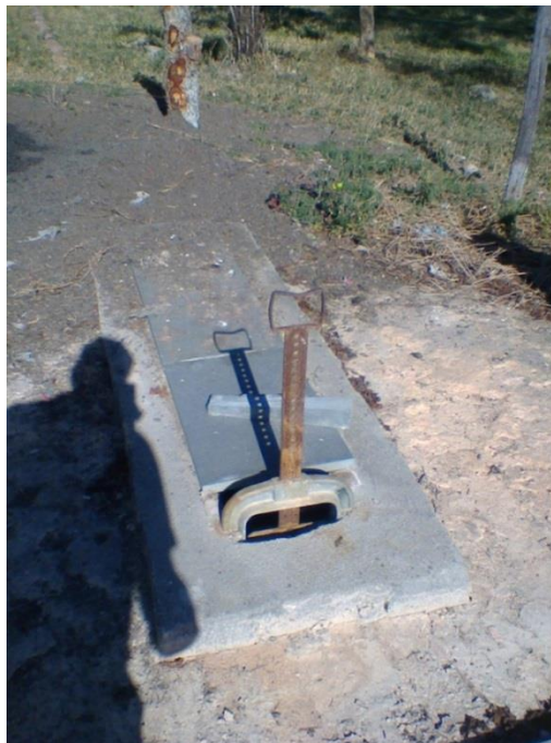
Figura 33: Gradeamento da ETE
