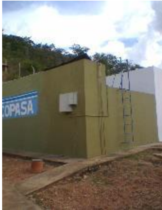
Figura 5 – Tanque de contato
