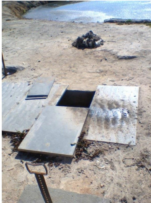
Figura 34: Caixa de areia (retenção de sólidos grosseiros)
