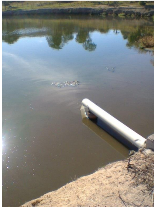
Figura 36: Passagem da 1ª lagoa de estabilização para a 2ª Lagoa
