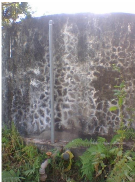
Figura 20 – Reservatório Localidade de Catita do Meio
