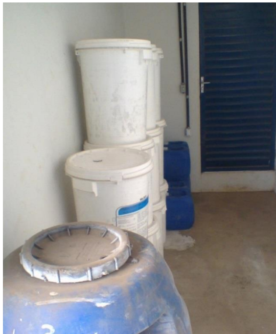
Figura 8 – Armazenamento de produtos químicos na ETA Fonte: Projeta Engenharia (2015)
