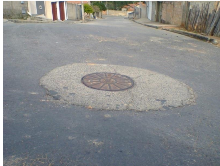
Figura 26: Poço de Visita no Bairro Cidade Nova
