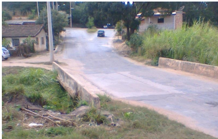
Figura 61: Área de alagamento - Ponte do córrego Maravilhas no bairro do Poção
