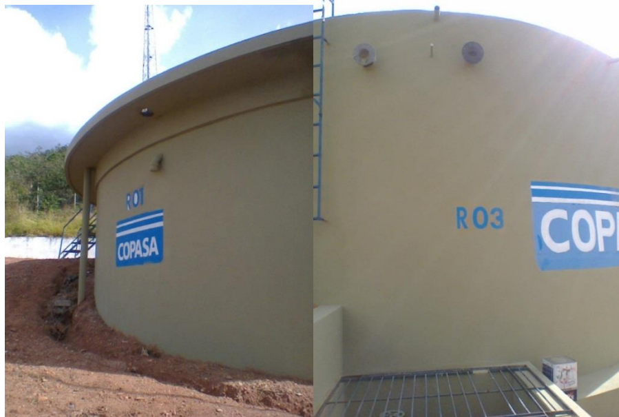
Figura 9 – Reservatório de água tratada da COPASA R1 e R3
