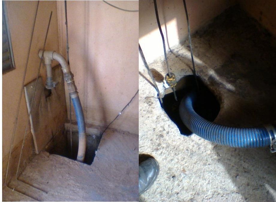
Figura 31: Localização da bomba (submersa) das E.E.E do Bairro Estiva e da Avenida Sete de Setembro
