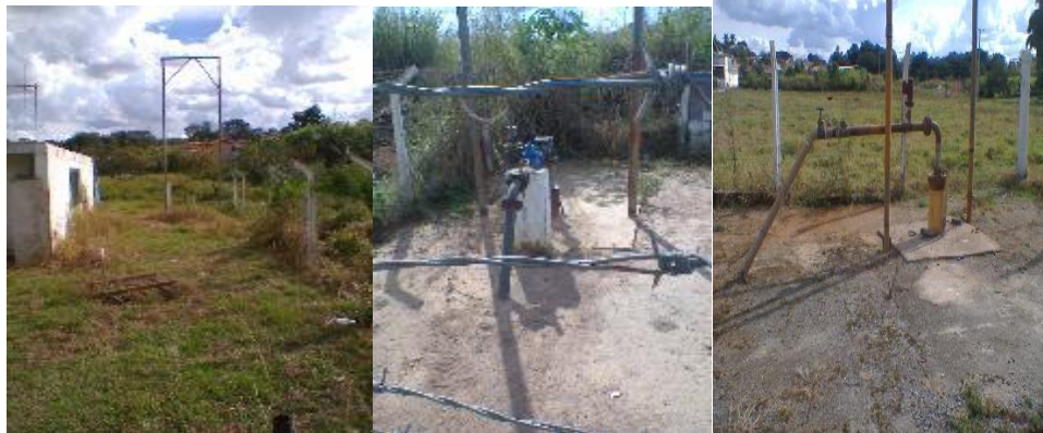
Figura 2 – Poços E-01, C - 01 e C - 15
