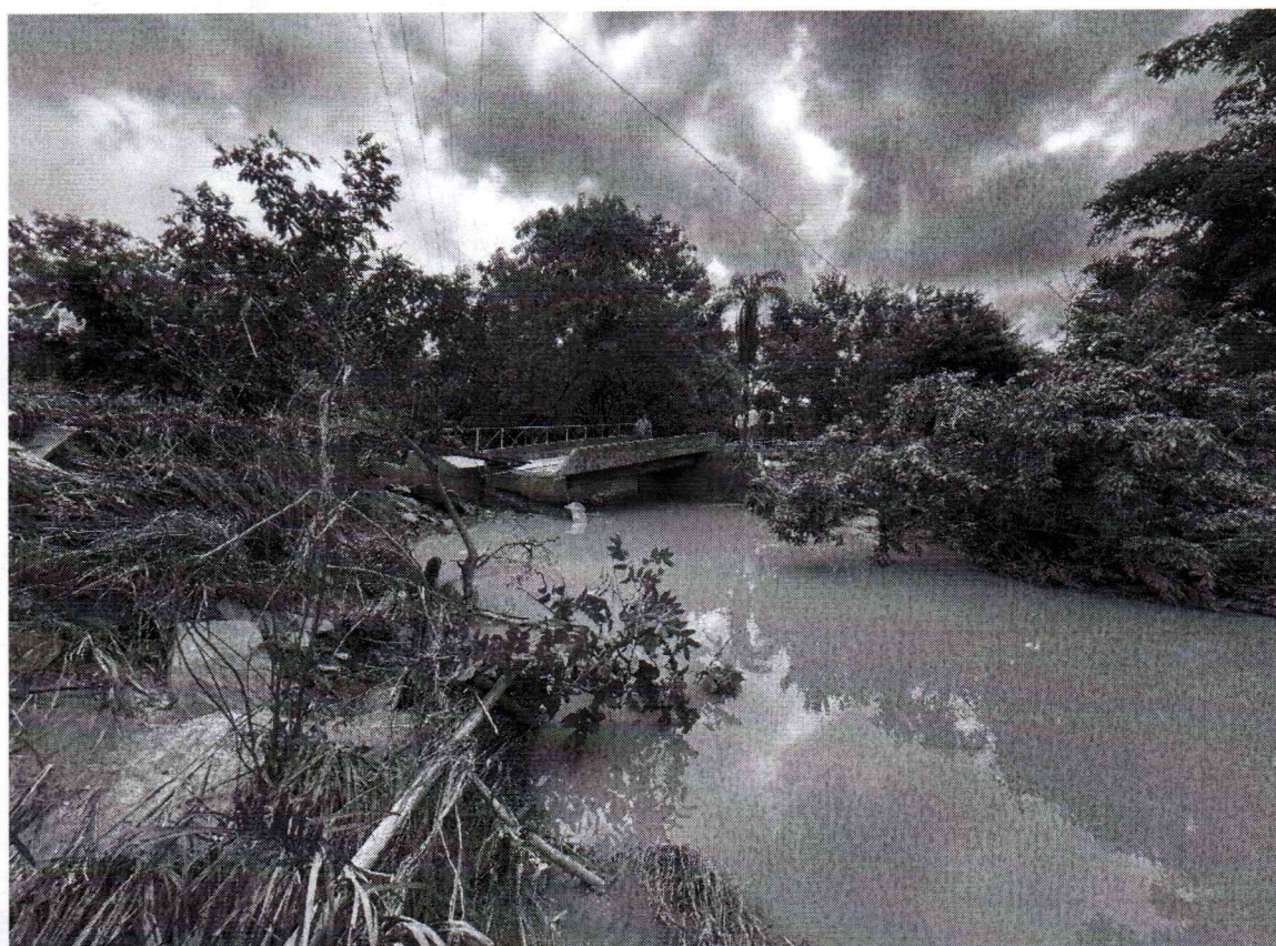
Vista geral da ponte sob o Rio Pardo
