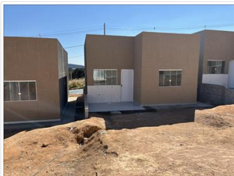
Registro do projeto de construção de casas populares em vistoria realizada no dia 29/08/25.
