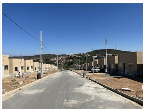
Registro do projeto de construção de casas populares em vistoria realizada no dia 29/08/25.
