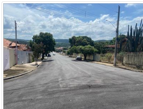
Constatação de recapeamento de vias do centro. Vistoria realizada em março/24.
