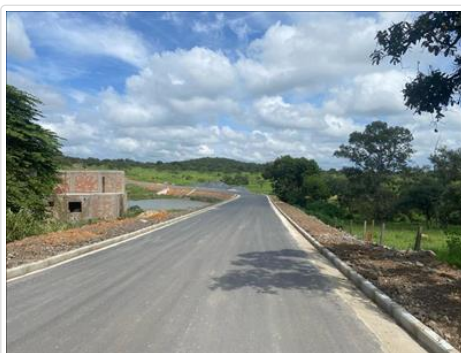
Constatação de pavimentação da estrada de Maravilhas a São José da Chácara. Vistoria realizada em março/24.
