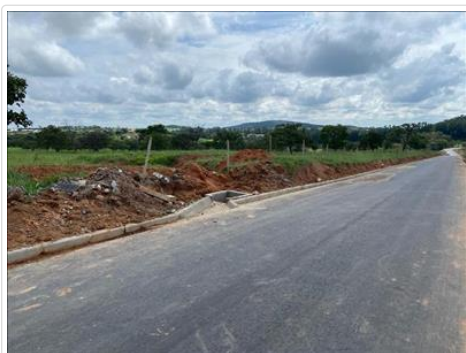
Constatação de pavimentação e drenagem superficial da estrada de Maravilhas a São José da Chácara. Vistoria realizada em março/24.
